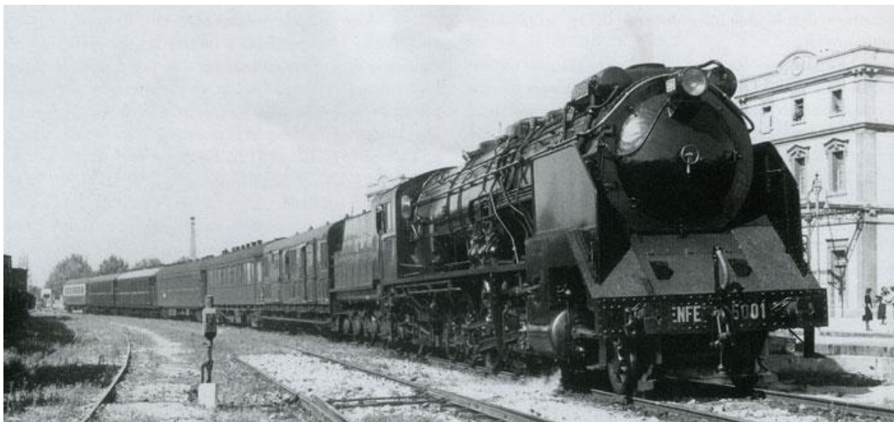
63. Locomotora 5001 durante sus pruebas.
